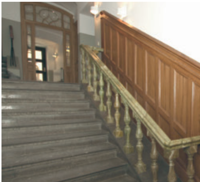
Marmoreringen av entréräcket ger hela trappentrén ett lyft.
