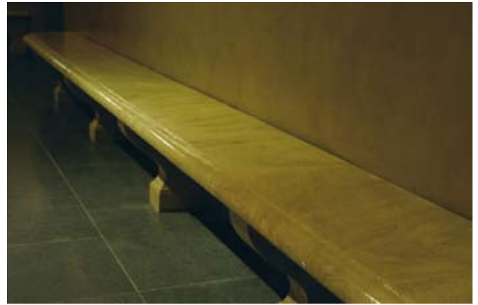
Marmoreringen av träbänkarna i Blå Hallen är ett av projekten som Jesper och Bernt utfört.
